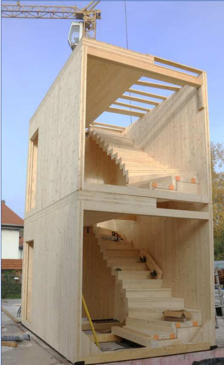
BSP-Treppe mit Stahlwange, Bauphase
