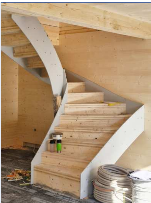
BSP-Treppe mit Stahlwange, Bauphase
